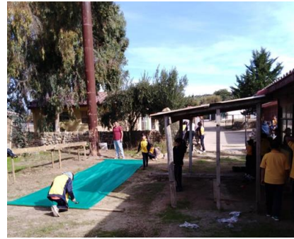
Figura 2. Trabajo en equipo de la construcción de los atrapanieblas. (Fuente: Autores y estudiantes)
