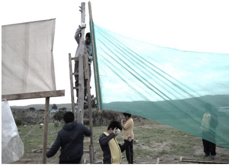
Figura 1. Instalación del segundo intento del atrapanieblas. (Fuente: Autores y estudiantes)
